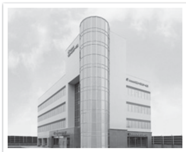
【2009年3月竣工の現社屋】
