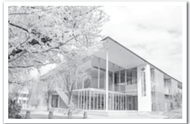
【新校舎KYOAI GLOBAL GATEWAY（令和3年竣工）】
