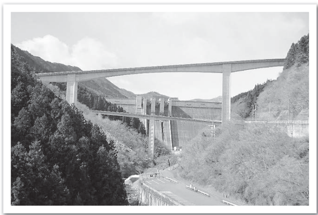
【秩父滝沢ダム ループ橋】
